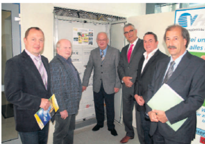
Am Schaltschrank zur PV-Anlage: (v.li.) Thomas Günther, (Technischer Leiter, VHM), Ingolf Garbenhorst (Sachgebietsleiter Stromversorgung, VHM), Klaus Burhenne (Bürgermeister und VHM-Aufsichtsratsvorsitzender), Arno Henning, Firma Volta.Konzept), Jochen Grebing (Firma Antaris Solar) und Werner Pfütz (Geschäftsführer, VHM).
