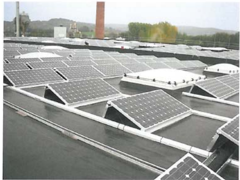
Bild 5. Die montierten und aufgeständerten Module auf dem Dach von Resopal
